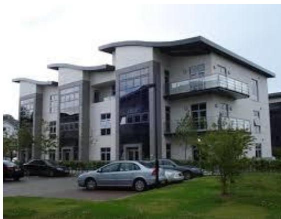
新オフィスの外観
