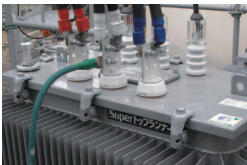
トッランナー変圧器
