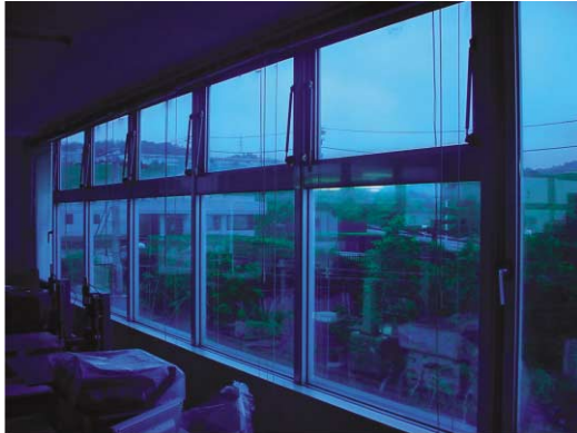
熱線遮断フィルムを窓の内面に施工
